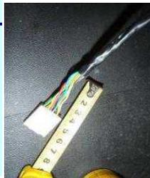
40. Нанесите третий слой изоляционной ленты, изменив направление наматывания и остановившись в 35 мм до отверстия в уплотнителе. Убедитесь, что при наматывании изоляционной ленты жгут проводов направлен вниз.
